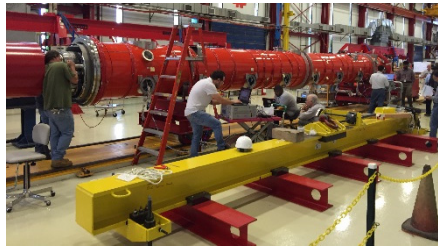
Montage av den första kryostaten som levereras till den nya anläggningen på SLAC.
